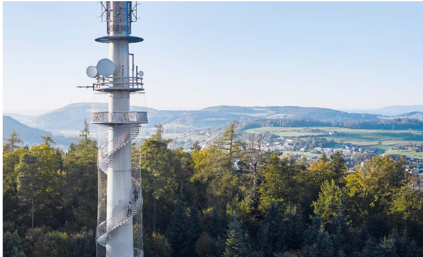
Vertikale Absturzsicherung | Brühlbergturm Winterthur, Schweiz Protection verticale contre les chutes | Brühlbergturm de Winterthur, Suisse Vertical fall protection | Brühlbergturm Winterthur, Switzerland
